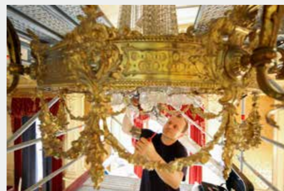
Der Hauptleuchter wird Kristall für Kristall demontiert, damit neue Leuchter nach seinem Vorbild hergestellt werden können.
