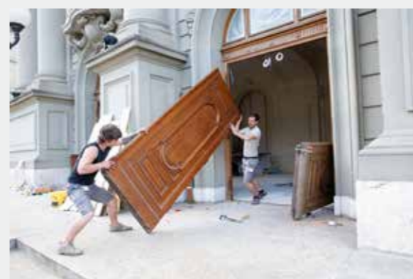
Die Restauration der hölzernen Haupteingangstüren
