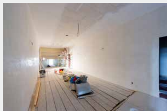
Das neue Foyer im 3. Rang des Theaters entsteht. Über dem neuen Durchgang bei der Mansarde wurde der neue Lüftungs-Monoblock montiert.
