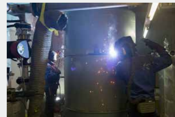
Schweisserarbeiten an der neuen, energieeffizienteren Heizung.
