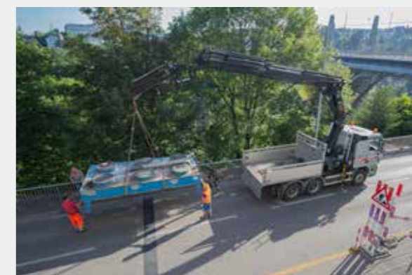
Abtransport des alten Rückkühlers an der Schütttestrasse.
