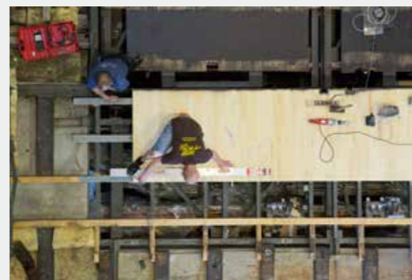
Präzisionsarbeit bei der Verlegung des neuen Bühnenbodens.
