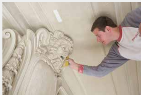
Schleifarbeiten an der Stuckatur des Kassenfoyers im Erdgeschoss.
