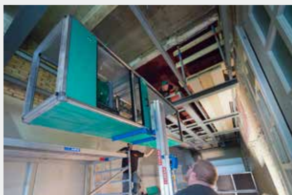
Einbau der neuen Monoblock-Kühlungsanlage.
