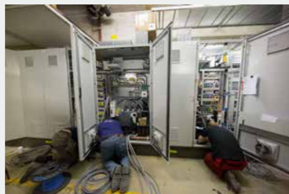
Die neuen Schaltschränke für die Untermaschinerie werden verkabelt.
